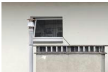
Le câble d'alimentation atteignant la prise
