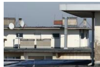
Le câble d'alimentation sur le toit
