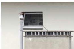
Le câble d'alimentation atteignant la prise
