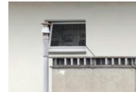
Le câble d'alimentation atteignant la prise
