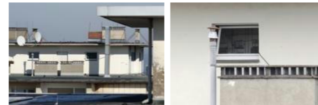
Le câble d'alimentation sur le toit
